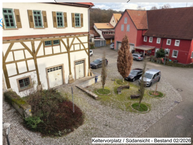
Keltervorplatz / Südansicht - Bestand 02/2026
