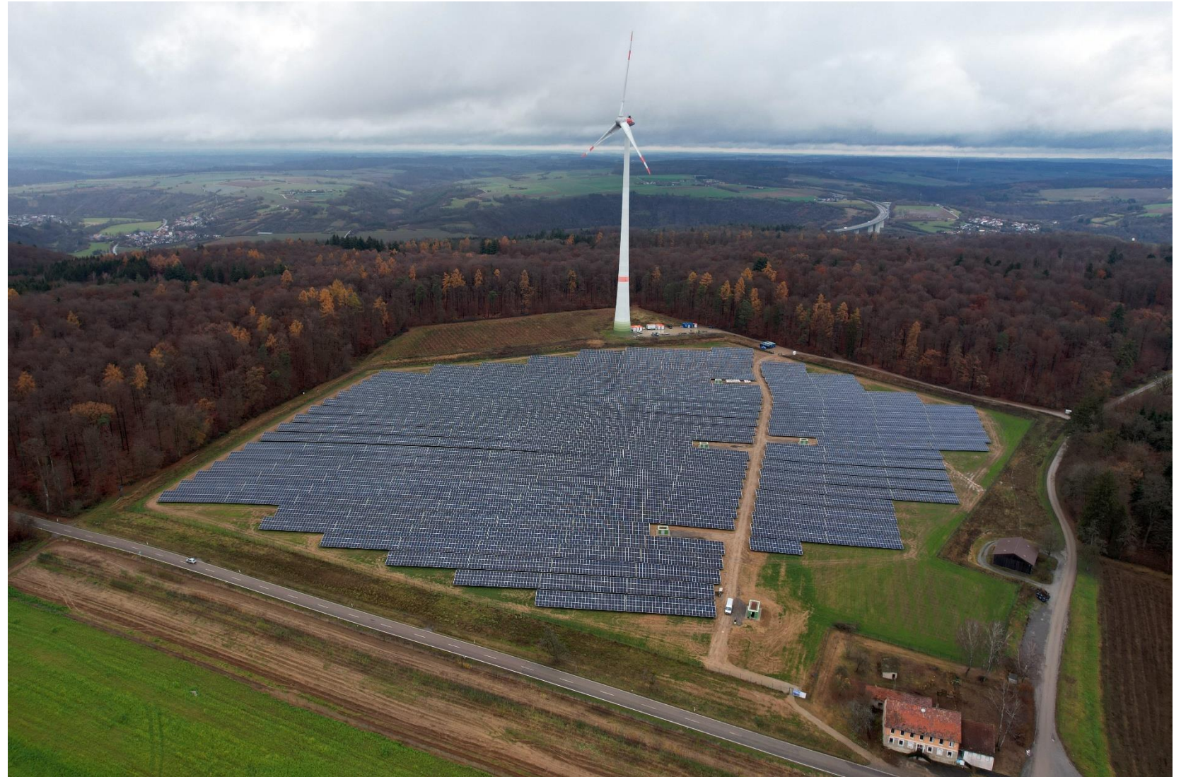
Hybridpark der BürgerEnergie Widdern: Freiflächen-Photovoltaik & Windenergie versorgen unter anderem die Wasserstoffherzeugung am DLR. Das verfallene Gebäude unten rechts wird mit Erlösen der FF-PV saniert und als Infozentrum und Versammlungsstätte ausgebaut.
