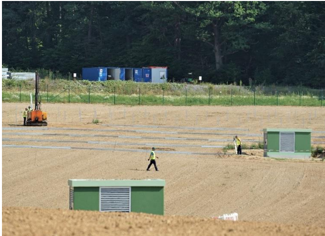
Rammen der Profile für die Unterkonstruktion
