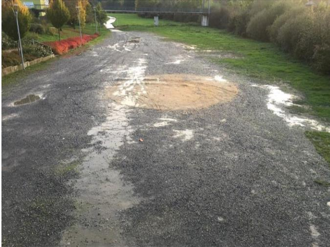
Ziel der Baumaßnahme ist es, das Oberflächengefälle des unbefestigten Festplatzes zwischen Stadthalle, Jagst und Fußgängerbrücke so zu optimieren, dass ein oberflächiges Abfließen von Niederschlagswasser wieder ermöglicht wird.
