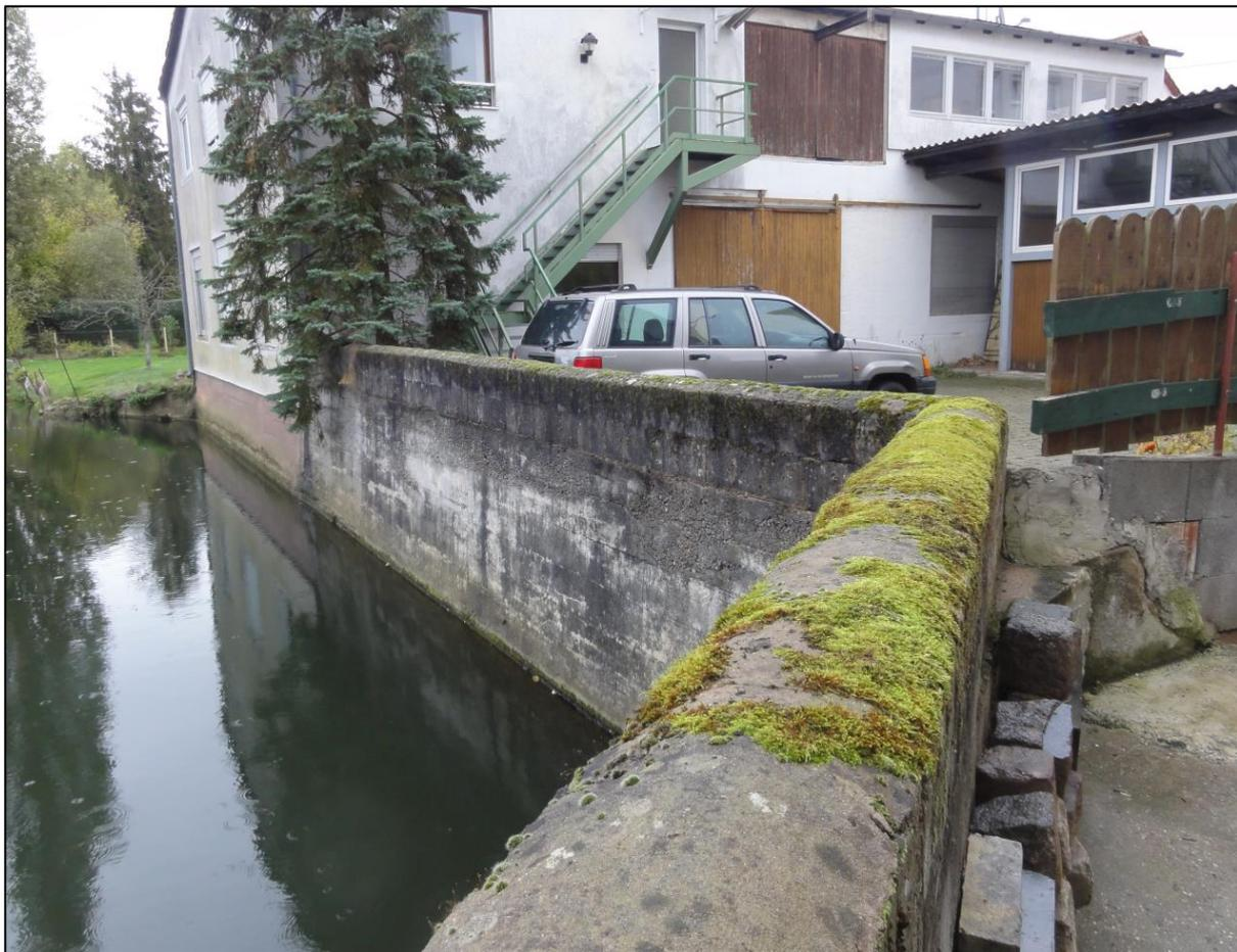
**Abbildung 4:** Hochwasserschutzmauer (Höhe ca. 1,10 m) oberhalb Wasserkraftanlage
