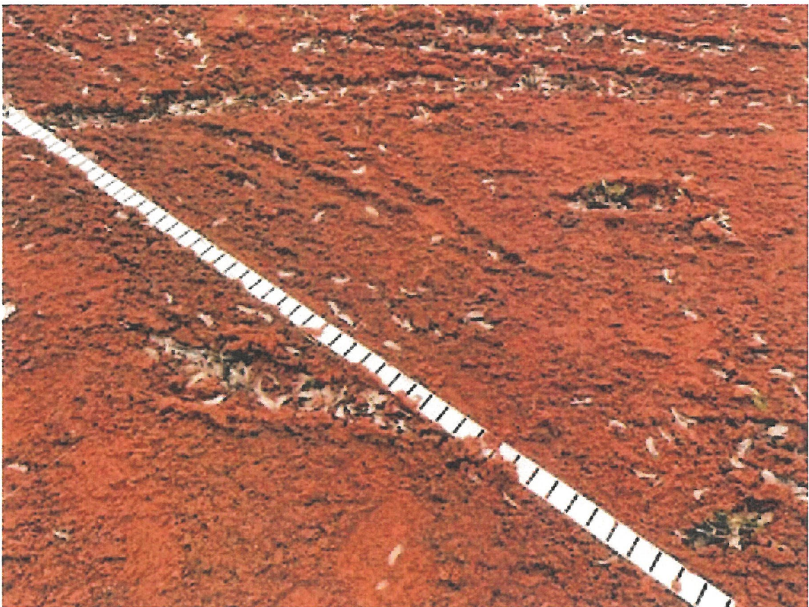
stark zerstörter Platz 3 und 4 (1)
