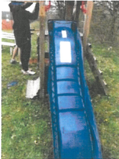
abgerissene Rutsche am Klettergerüst
