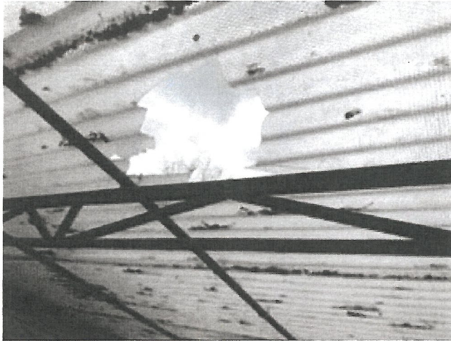
beschädigte Terrassenüberdachung
