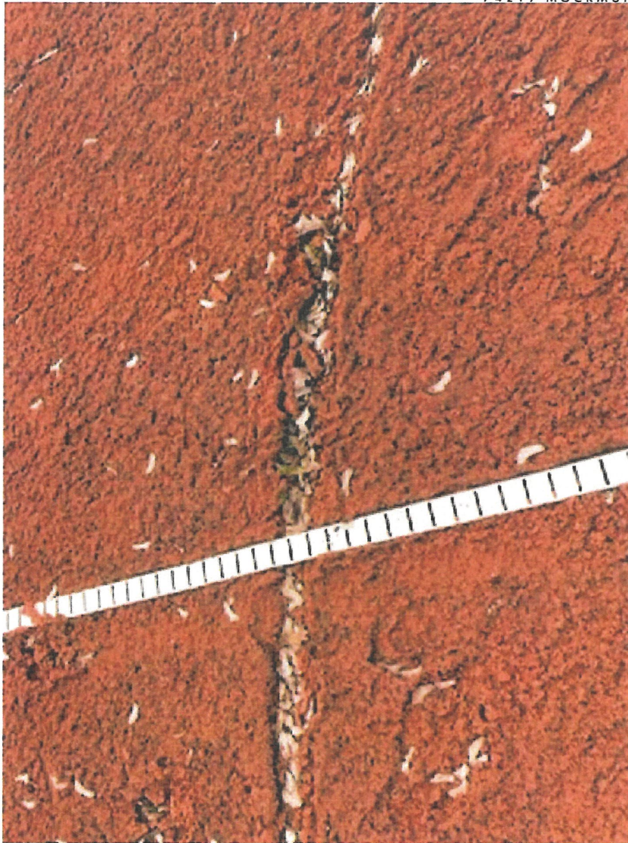
stark zerstörter Platz 3 und 4 (2)
