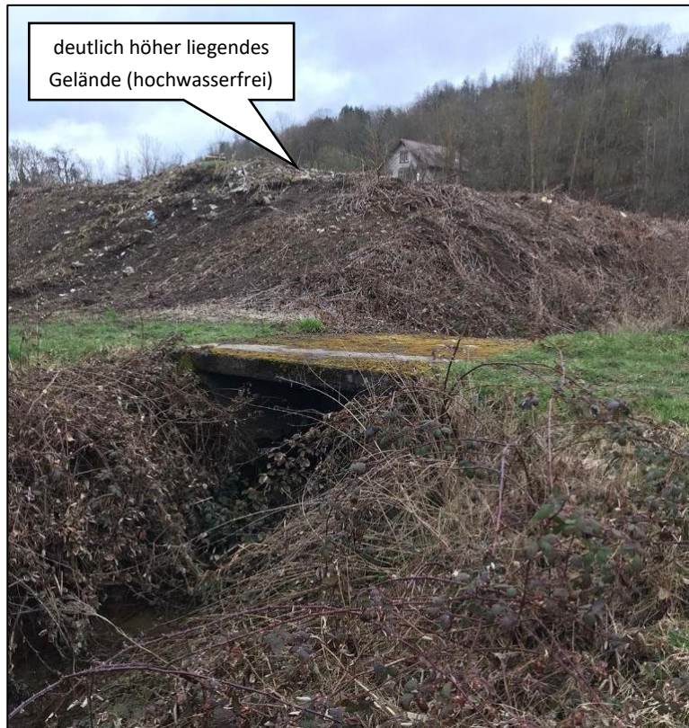
Abbildung 9: Ersteinbach - Blick in Richtung Überfahrt nach oberstrom
