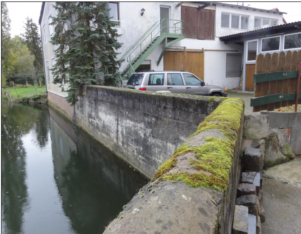
Abbildung 4: Hochwasserschutzmauer (Höhe ca. 1,10 m) oberhalb Wasserkraftanlage
